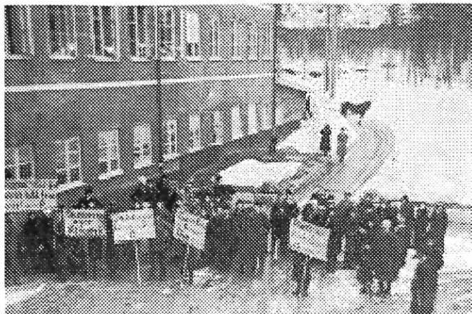
Sandträsk sanatorium, demonstration 1935 från Boden Överluleå ForskarFörenings bildarkiv
